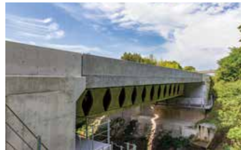
“さびない橋” 別荘谷橋
