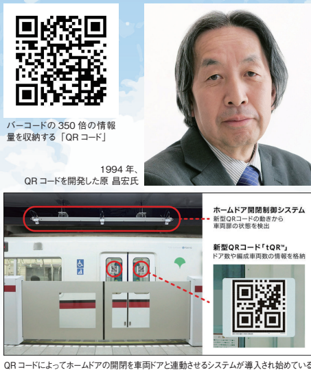
QRコードによってホームドアの開閉を車両ドアと連動させるシステムが導入され始めている
