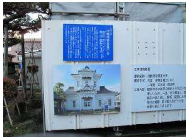
旧鶴岡警察署庁舎（現在工事中）
