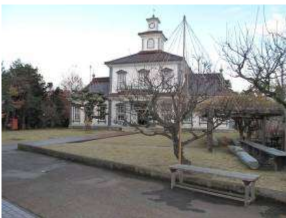
旧西田川郡役所
